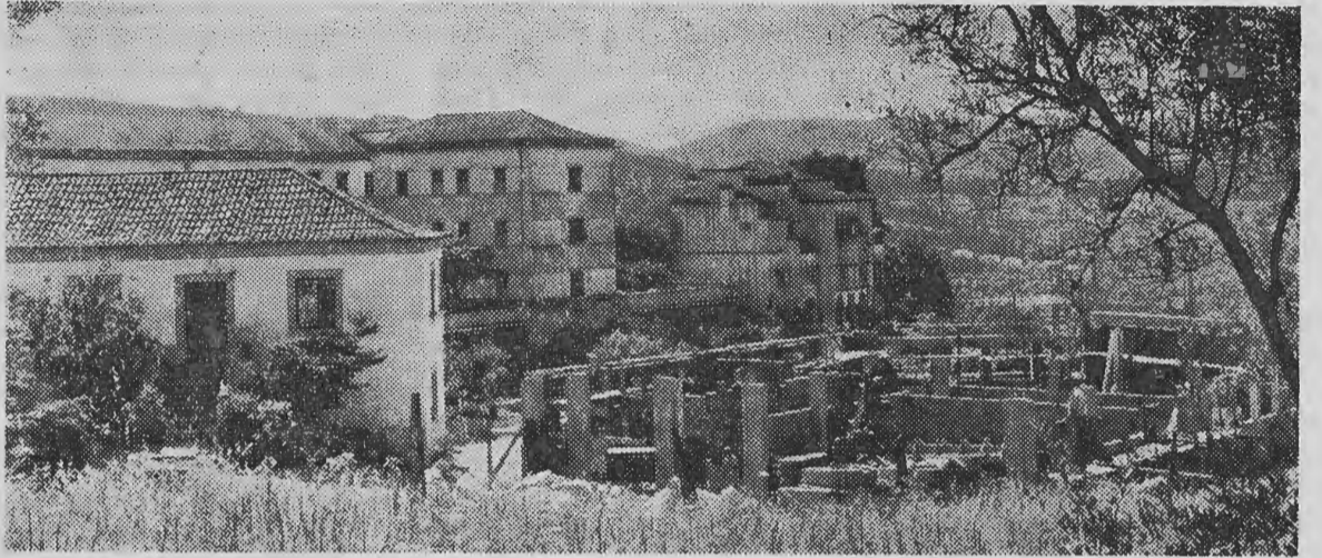
MAIS UMA PERSPECTIVA DA CONSTRUÇÃO DO NOVO LAR DE COIMBRA
